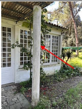
Photo n° PhA002 Localisation : Parties extérieures Ouvrage : 3 - Parois verticales intérieures - Poteaux Partie d'ouvrage : Coffrage perdu Description : Coffrage perdu
