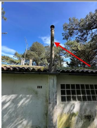
Photo n° PhA003 Localisation : Toiture Ouvrage : 6 - Conduits et accessoires intérieurs - Conduits de fluides (air, eau, vapeur, fumée, échappement, autres fluides) Partie d'ouvrage : Conduit en fibres-ciment Description : Conduit en fibres-ciment + chapeau
